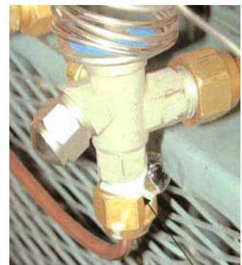
Figura 10. Válvula de expansión.
